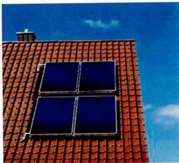
Figura 17 -Panouri fotovoltaice pentru producere energie electrica
